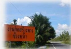
ติดตั้งป้ายเตือนก่อนถึงพื้นที่ก่อสร้าง
